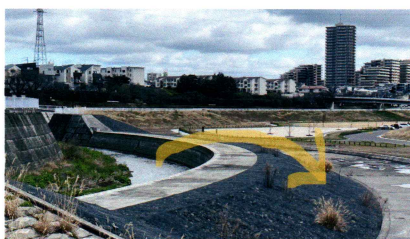
下土棚遊水地公園(A池)洪水は越流堤から右側の遊水地に流れる
